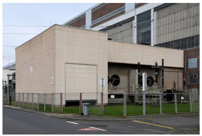
Kraftwerk Niederaußem: Transformatorenfeld Block D, Einhausung der Maschinentrafos, Ansicht von Südosten; Foto: 17.08.2023 Fotograf/Urheber: Dr. Norbert Gilson
