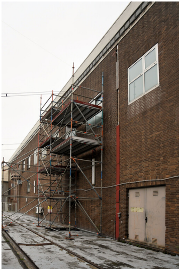
Kraftwerk Niederaußem: Schaltanlagenvorbau, Block D, Ansicht von Südosten; Foto: 17.08.2023 Fotograf/Urheber: Dr. Norbert Gilson
