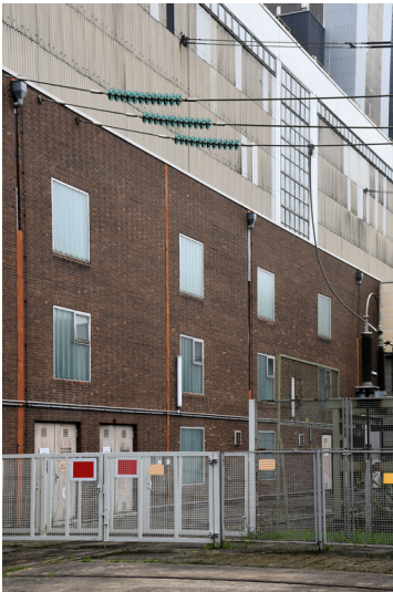
Kraftwerk Niederaußem: Schaltanlagenvorbau, Block C1/C2, östlicher Bauteil, Ansicht von Südwesten; Foto: 17.08.2023 Fotograf/Urheber: Dr. Norbert Gilson
