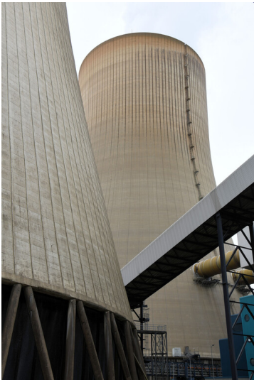
Kraftwerk Niederaußem: Kühlturm K, Ansicht von Südwesten; Foto: 15.08.2023 Fotograf/Urheber: Dr. Norbert Gilson
