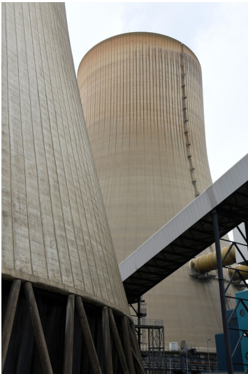
Kraftwerk Niederaußem: Kühlturm K, Ansicht von Südwesten; Foto: 15.08.2023 Fotograf/Urheber: Dr. Norbert Gilson
