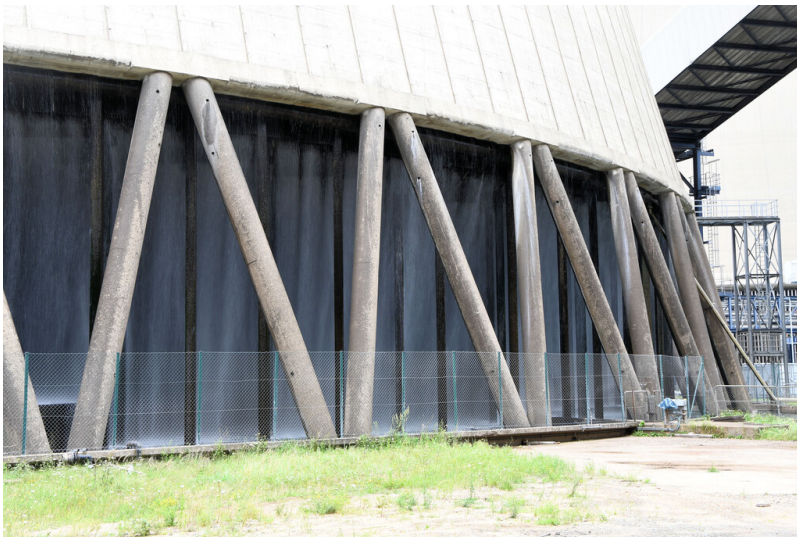
Kraftwerk Niederaußem: Kühlturm H, Schrägstreben und Spannbetonring; Foto: 15.08.2023 Fotograf/Urheber: Dr. Norbert Gilson
