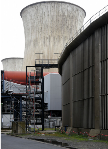
Kraftwerk Niederaußem: Kühlturm G, Ansicht von Osten; Foto: 15.08.2023 Fotograf/Urheber: Dr. Norbert Gilson
