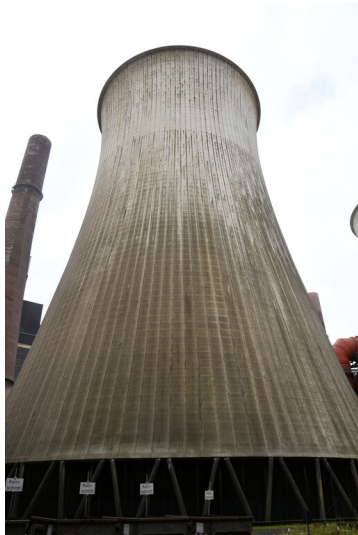
Kraftwerk Niederaußem: Kühlturm F, Ansicht von Norden; Foto: 15.08.2023 Fotograf/Urheber: Dr. Norbert Gilson
