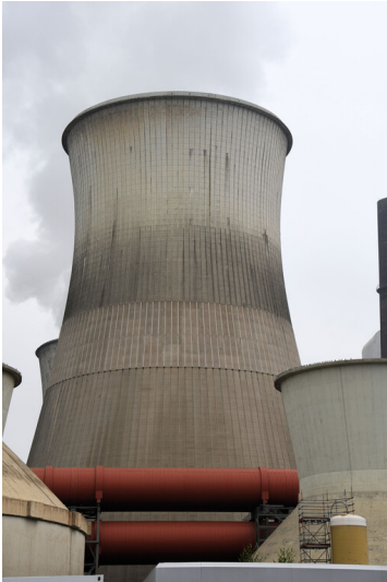
Kraftwerk Niederaußem: Kühlturm D, Ansicht von Westen; Foto: 17.08.2023 Fotograf/Urheber: Dr. Norbert Gilson
