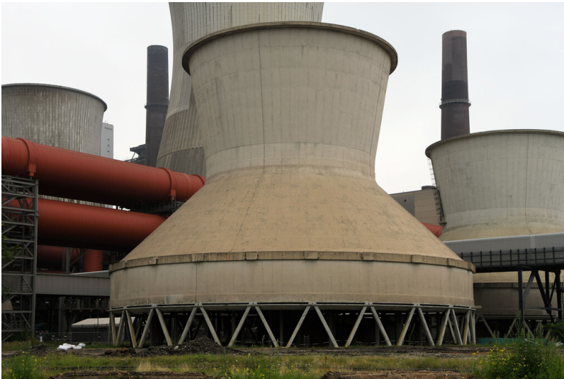
Kraftwerk Niederaußem: Kühlturm 6, Ansicht von Südwesten; Foto: 17.08.2023 Fotograf/Urheber: Dr. Norbert Gilson
