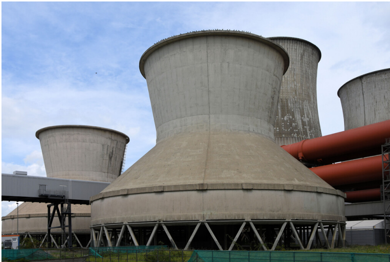
Kraftwerk Niederaußem: Kühlturm 5, Ansicht von Südwesten; Foto: 15.08.2023 Fotograf/Urheber: Dr. Norbert Gilson
