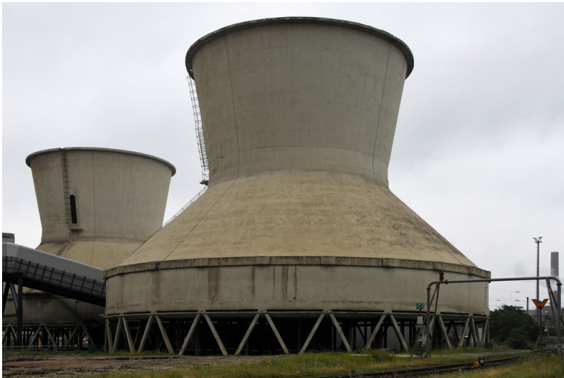
Kraftwerk Niederaußem: Kühlturm 3, Ansicht von Norden; Foto: 17.08.2023 Fotograf/Urheber: Dr. Norbert Gilson
