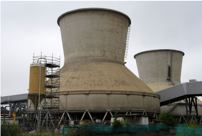
Kraftwerk Niederaußem: Kühlturm 2, Ansicht von Südosten; Foto: 17.08.2023 Fotograf/Urheber: Dr. Norbert Gilson
