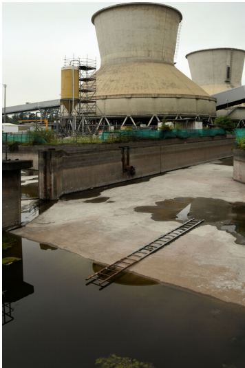
Kraftwerk Niederaußem: Kühlwasserbecken, im Hintergrund Kühlturm 2, Ansicht von Südosten; Foto: 17.08.2023 Fotograf/Urheber: Dr. Norbert Gilson
