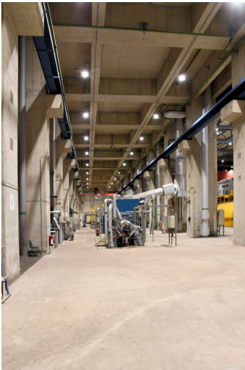
Kraftwerk Niederaußem: Scherwbau Block K, Innenansicht von Westen; Foto: 15.08.2023 Fotograf/Urheber: Dr. Norbert Gilson
