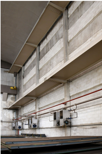
Kraftwerk Niederaußem: Maschinenhaus Block H, offensichtlich ursprünglich als Provisorium angelegte östliche Außenwand, Innenansicht von Süden; Foto: 15.08.2023 Fotograf/Urheber: Dr. Norbert Gilson
