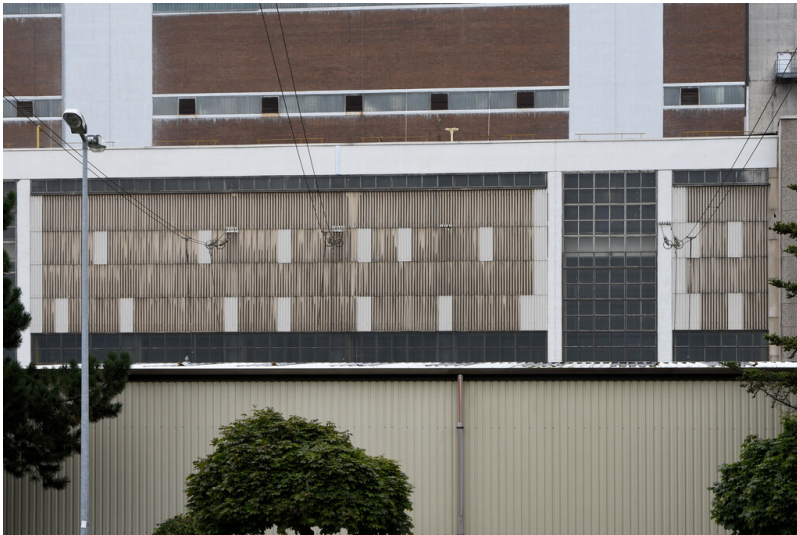
Kraftwerk Niederaußem: Maschinenhaus Block F, Ansicht von Süden; Foto: 15.08.2023 Fotograf/Urheber: Dr. Norbert Gilson
