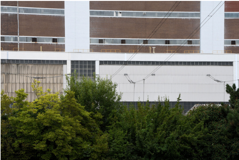
Kraftwerk Niederaußem: Maschinenhaus Block E, Ansicht von Süden; Foto: 15.08.2023 Fotograf/Urheber: Dr. Norbert Gilson
