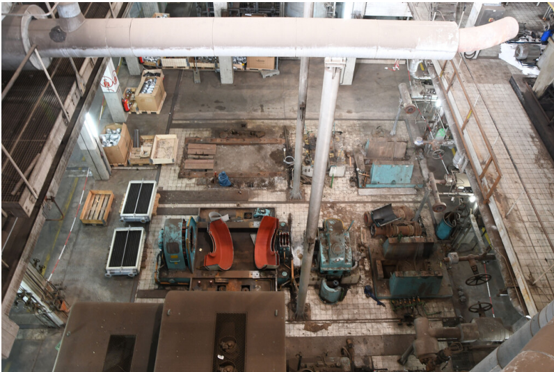
Kraftwerk Niederaußem: Maschinenhaus Block D, Ebene +0 m mit demontierten Anlagenteilen; Foto: 15.08.2023 Fotograf/Urheber: Dr. Norbert Gilson
