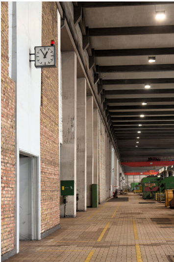
Kraftwerk Niederaußem: Maschinenhaus, Schwerbauseite, Innenansicht von Westen vom Standpunkt Block A; Foto: 15.08.2023 Fotograf/Urheber: Dr. Norbert Gilson
