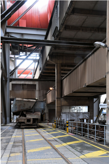
Kraftwerk Niederaußem: Asche-Waggonverladung von Block E, Ansicht von Osten; Foto: 15.08.2023 Fotograf/Urheber: Dr. Norbert Gilson
