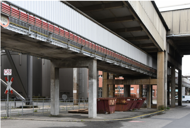
Kraftwerk Niederaußem: Aschefernband in Höhe der Verteilerstation 2, Ansicht von Nordosten; Foto: 15.08.2023 Fotograf/Urheber: Dr. Norbert Gilson
