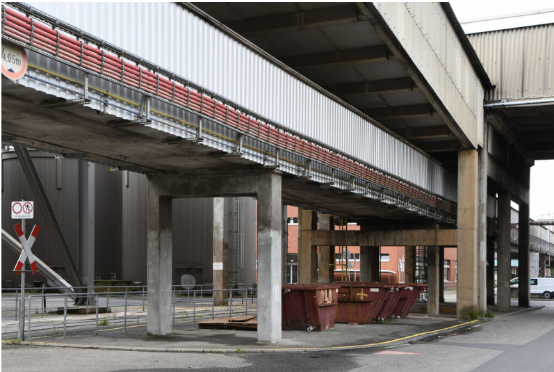
Kraftwerk Niederaußem: Aschefernband in Höhe der Verteilerstation 2, Ansicht von Nordosten; Foto: 15.08.2023 Fotograf/Urheber: Dr. Norbert Gilson
