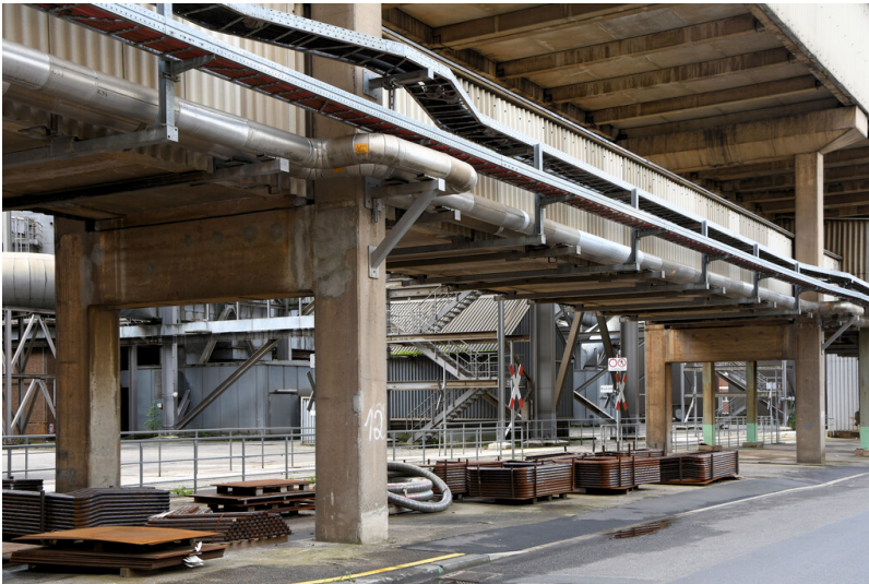
Kraftwerk Niederaußem: Aschebandbrücke in Höhe der Blöcke A/B, Ansicht von Nordosten; Foto: 15.08.2023 Fotograf/Urheber: Dr. Norbert Gilson
