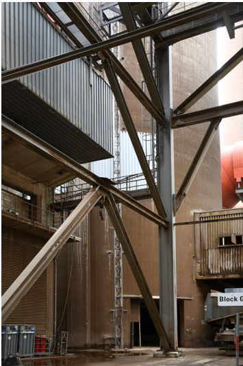
Kraftwerk Niederaußem: Entaschung Block G, Ausleitung des Aschebandes aus dem Schornstein G, Ansicht von Nordosten; Foto: 15.08.2023 Fotograf/Urheber: Dr. Norbert Gilson
