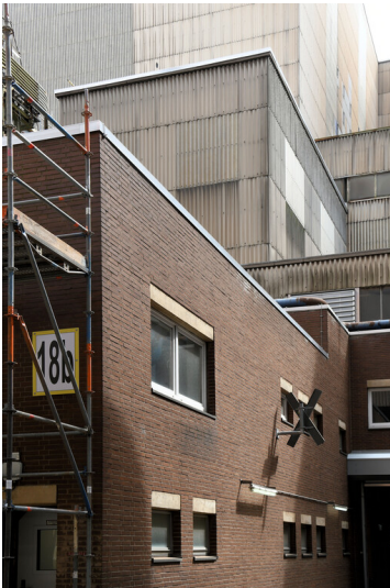
Kraftwerk Niederaußem: Entaschung Block E, Asche-Zwischenbunker, Ansicht von Nordwesten; Foto: 15.08.2023 Fotograf/Urheber: Dr. Norbert Gilson
