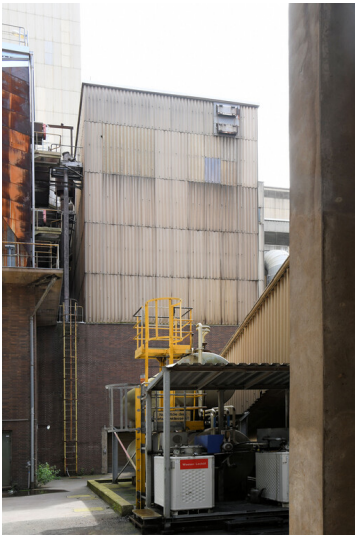
Kraftwerk Niederaußem: Entaschung Block D, Asche-Zwischenbunker, Ansicht von Norden; Foto: 15.08.2023 Fotograf/Urheber: Dr. Norbert Gilson
