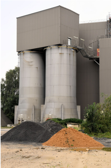
Kraftwerk Niederaußem: Gipsentsorgung, Gipssilos, Ansicht von Südwesten; Foto: 17.08.2023 Fotograf/Urheber: Dr. Norbert Gilson
