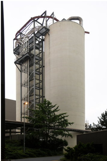
Kraftwerk Niederaußem: Kalksilos, Ansicht von Osten; Foto: 17.08.2023 Fotograf/Urheber: Dr. Norbert Gilson
