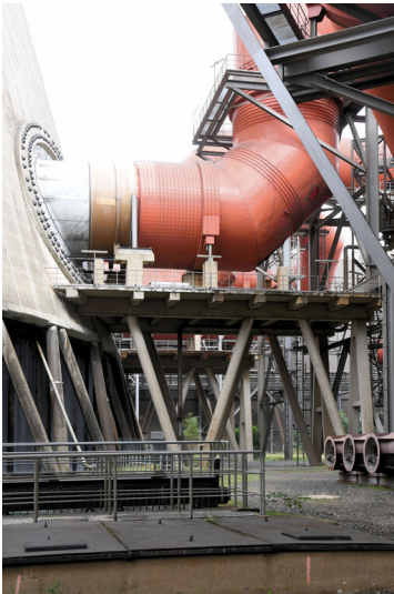
Kraftwerk Niederaußem: Reingaseinleitung Kühlturm G, Ansicht von Süden; Foto: 15.08.2023 Fotograf/Urheber: Dr. Norbert Gilson
