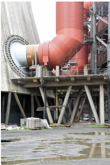
Kraftwerk Niederaußem: Reingaseinleitung Kühlturm F, Ansicht von Norden; Foto: 15.08.2023 Fotograf/Urheber: Dr. Norbert Gilson
