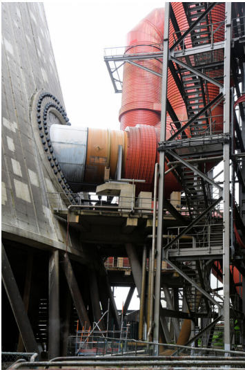
Kraftwerk Niederaußem: Reingaseinleitung Kühlturm E, Ansicht von Südosten; Foto: 17.08.2023 Fotograf/Urheber: Dr. Norbert Gilson
