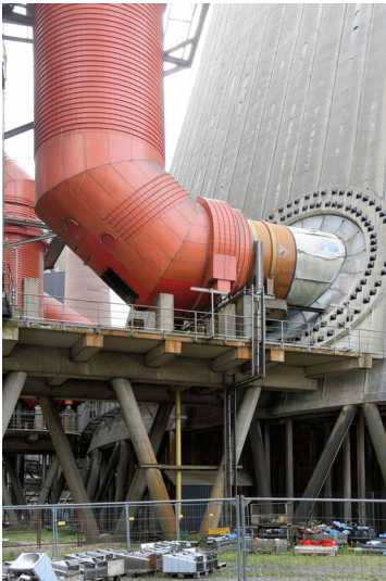
Kraftwerk Niederaußem: Reingaseinleitung Kühlturm D, Ansicht von Nordwesten; Foto: 15.08.2023 Fotograf/Urheber: Dr. Norbert Gilson
