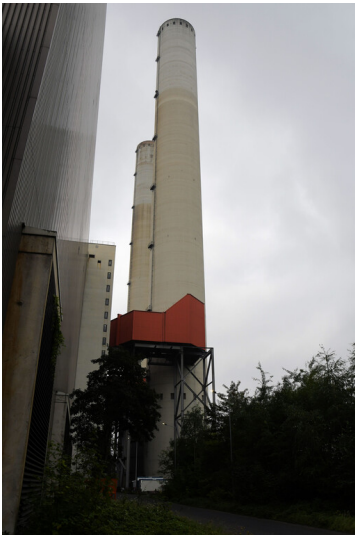
Kraftwerk Niederaußem: REA-(Bypass-)Kamin 2, Ansicht von Nordosten; Foto: 17.08.2023 Fotograf/Urheber: Dr. Norbert Gilson
