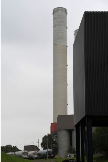
Kraftwerk Niederaußem: REA-Kamin 1, Ansicht von Südwesten; Foto: 17.08.2023 Fotograf/Urheber: Dr. Norbert Gilson
