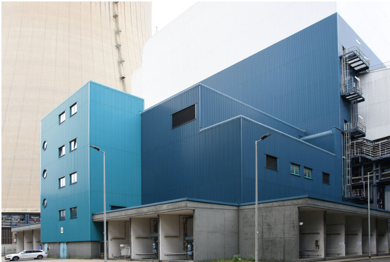
Kraftwerk Niederaußem: Schaltanlagegebäude 2, Ansicht von Südwesten; Foto: 15.08.2023 Fotograf/Urheber: Dr. Norbert Gilson
