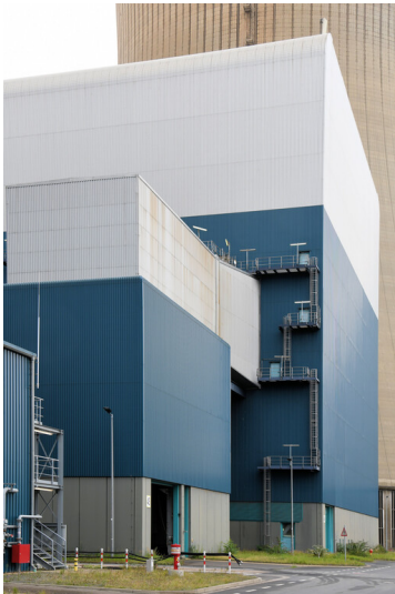
Kraftwerk Niederaußem: REA-Gebäude Block K, Einleitung eines Rauchgaskanals aus dem Saugzuggebäude, Ansicht von Südosten; Foto: 15.08.2023 Fotograf/Urheber: Dr. Norbert Gilson
