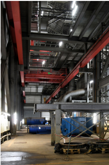
Kraftwerk Niederaußem: REA-Wäschergebäude, Innenansicht; Foto: 17.08.2023 Fotograf/Urheber: Dr. Norbert Gilson
