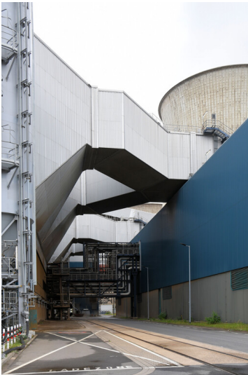
Kraftwerk Niederaußem: Elektrofilter Block K, Ausgänge zum Saugzuggebäude, Ansicht von Osten; Foto: 15.08.2023 Fotograf/Urheber: Dr. Norbert Gilson
