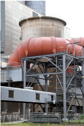
Kraftwerk Niederaußem: Schornstein-Fundamentsockel Block H, Ansicht von Nordosten; Foto: 15.08.2023 Fotograf/Urheber: Dr. Norbert Gilson
