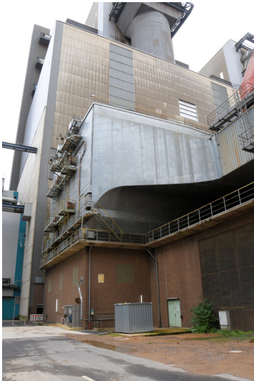
Kraftwerk Niederaußem: Elektrofilter Block H, Ansicht von Norden; Foto: 15.08.2023 Fotograf/Urheber: Dr. Norbert Gilson
