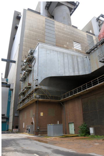
Kraftwerk Niederaußem: Elektrofilter Block H, Ansicht von Norden; Foto: 15.08.2023 Fotograf/Urheber: Dr. Norbert Gilson
