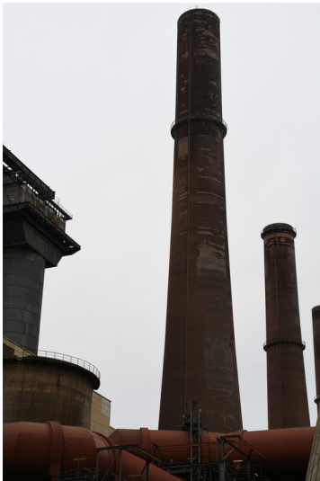
Kraftwerk Niederaußem: Schornstein Block G, Ansicht von Nordosten; Foto: 15.08.2023 Fotograf/Urheber: Dr. Norbert Gilson
