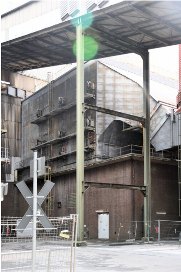
Kraftwerk Niederaußem: Elektrofilter Block F, Ansicht von Norden; Foto: 15.08.2023 Fotograf/Urheber: Dr. Norbert Gilson
