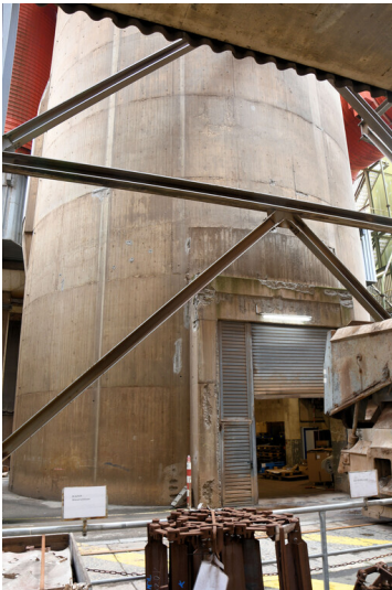
Kraftwerk Niederaußem: Schornstein Block E, Stahlbetonunterbau, Ansicht von Norden; Foto: 15.08.2023 Fotograf/Urheber: Dr. Norbert Gilson
