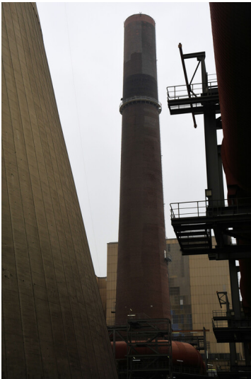
Kraftwerk Niederaußem: Schornstein Block D, Ansicht von Nordwesten; Foto: 17.08.2023 Fotograf/Urheber: Dr. Norbert Gilson
