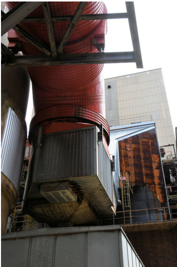
Kraftwerk Niederaußem: Elektrofilter Block D, Anschluss an den Rohgaskanal, Ansicht von Nordwesten; Foto: 15.08.2023 Fotograf/Urheber: Dr. Norbert Gilson
