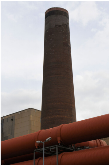
Kraftwerk Niederaußem: Schornsteinsäule Block C1/C2, Ansicht von Nordwesten; Foto: 15.08.2023 Fotograf/Urheber: Dr. Norbert Gilson
