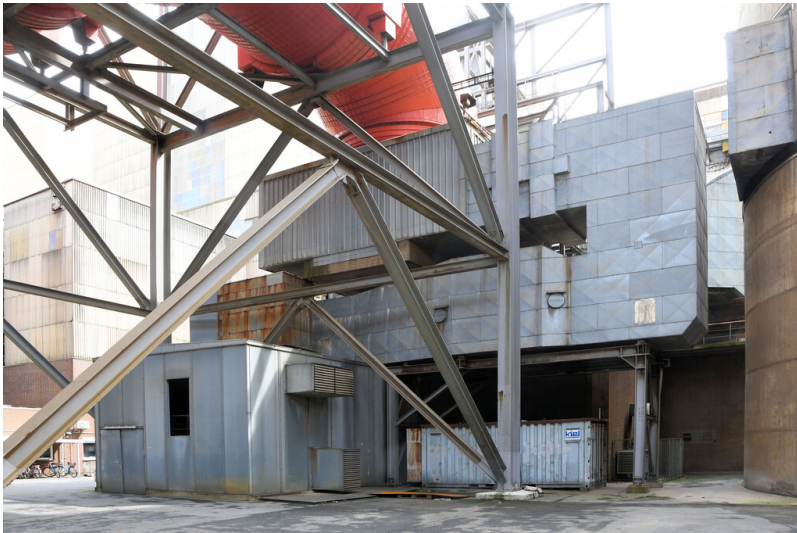
Kraftwerk Niederaußem: Elektrofilter Block C1/C2, Anschluss Elektrofilter von Halblastkessel C2 an Rohgaskanal, Ansicht von Nordwesten; Foto: 15.08.2023 Fotograf/Urheber: Dr. Norbert Gilson
