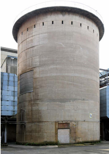
Kraftwerk Niederaußem: Schornstein-Fundamentsockel Blöcke A/B, Ansicht von Norden; Foto: 15.08.2023 Fotograf/Urheber: Dr. Norbert Gilson
