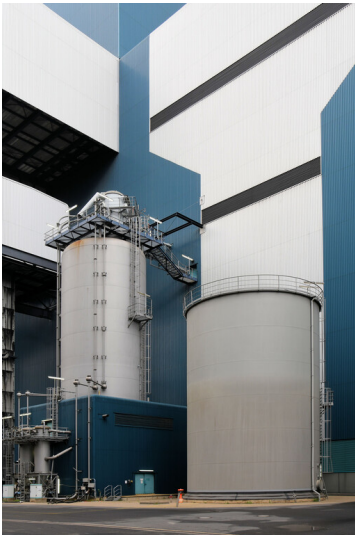
Kraftwerk Niederaußem: BoA-Block K, Zünderbrennstoffanlage, Ansicht von Südwesten; Foto: 15.08.2023 Fotograf/Urheber: Dr. Norbert Gilson
