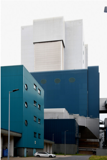
Kraftwerk Niederaußem: Kesselhaus Block K, Ansicht von Norden; Foto: 15.08.2023 Fotograf/Urheber: Dr. Norbert Gilson
