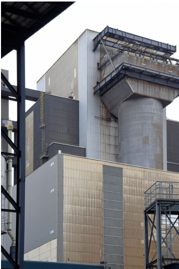
Kraftwerk Niederaußem: Kesselhaus Block H, Rauchgasleerzugkanal, Ansicht von Norden; Foto: 15.08.2023 Fotograf/Urheber: Dr. Norbert Gilson
